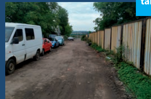
Powstańców Warszawskich przed remontem.
