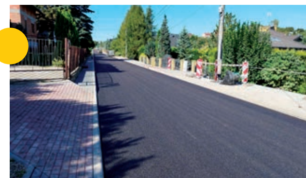
Ul. Kawalca po kompleksowej przebudowie.
