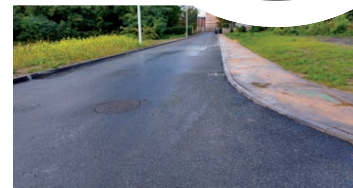
Powstańców Warszawskich po remoncie.
