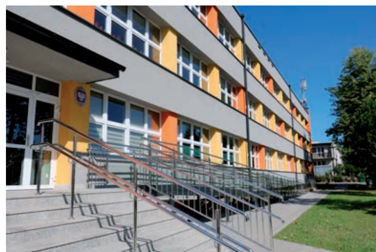
Miejska Szkoła Podstawowa nr 5 przeszła termomodernizację.
