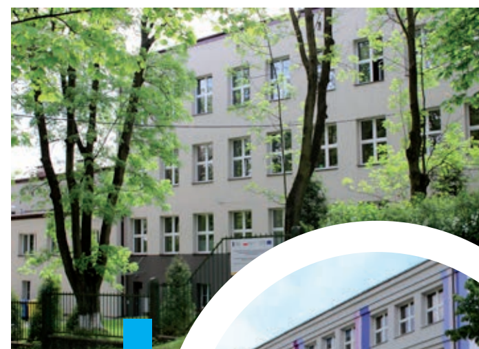
Nowa elewacja MSP nr 2.
