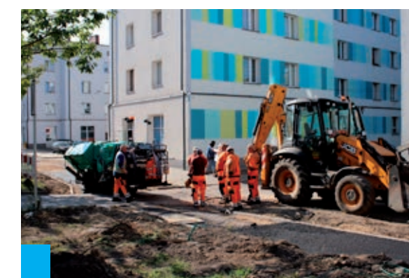
Budowa ścieżek na osiedlu Wieczorka.
