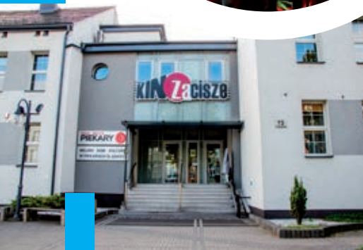
Budynek kina po remoncie.
