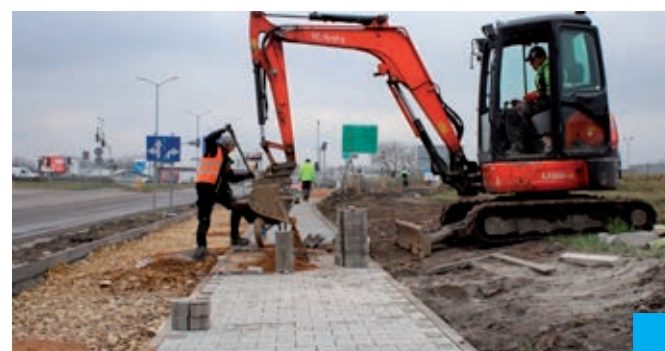
Intensywne prace przy przebudowie ul. Miarki i Podmiejskiej oraz DW 911.
