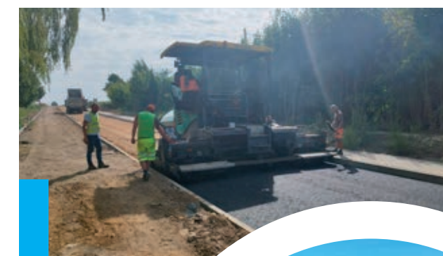
Trwa budowa ul. Radzionkowskiej.
