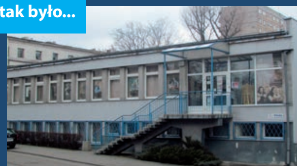
Budynek biblioteki przed rozpoczęciem remontu.
