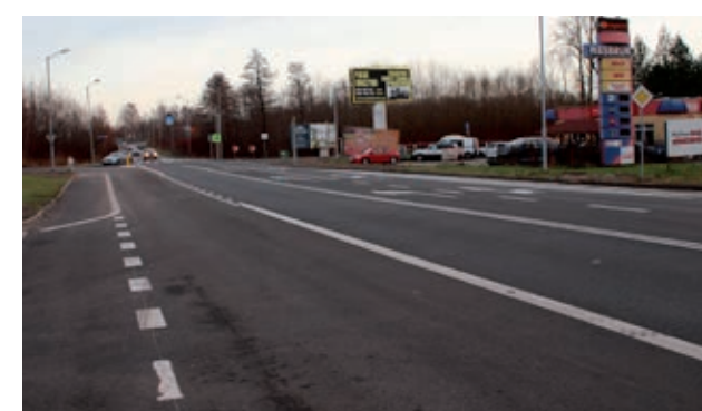
Na wyremontowanym skrzyżowaniu DK 94 z ul. Bednorza pojawiła się też sygnalizacja.
