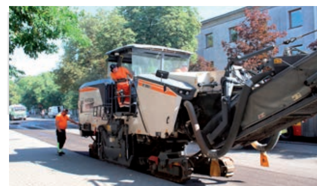
Ul. Bytomska w trakcie remontu.
