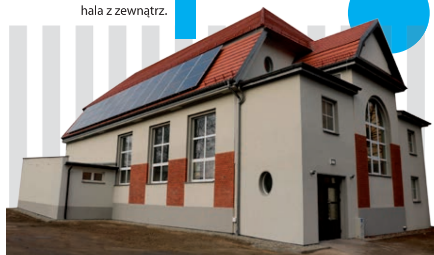
MSP nr 1 hala z zewnątrz.
