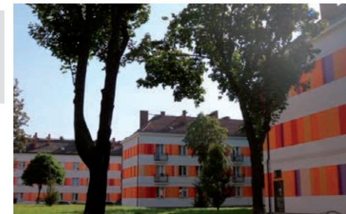
Pierwsze efekty prac remontowych.
