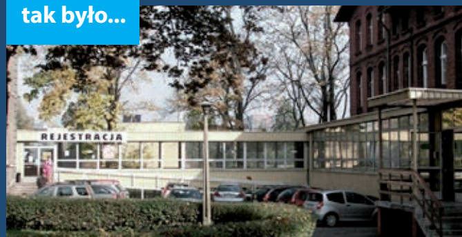
Stary szpital przed rozpoczęciem przebudowy.
